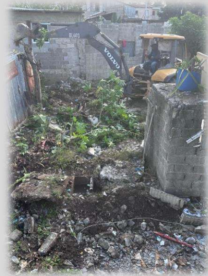
Ilustración 2. Limpieza y Nivelación del terreno
